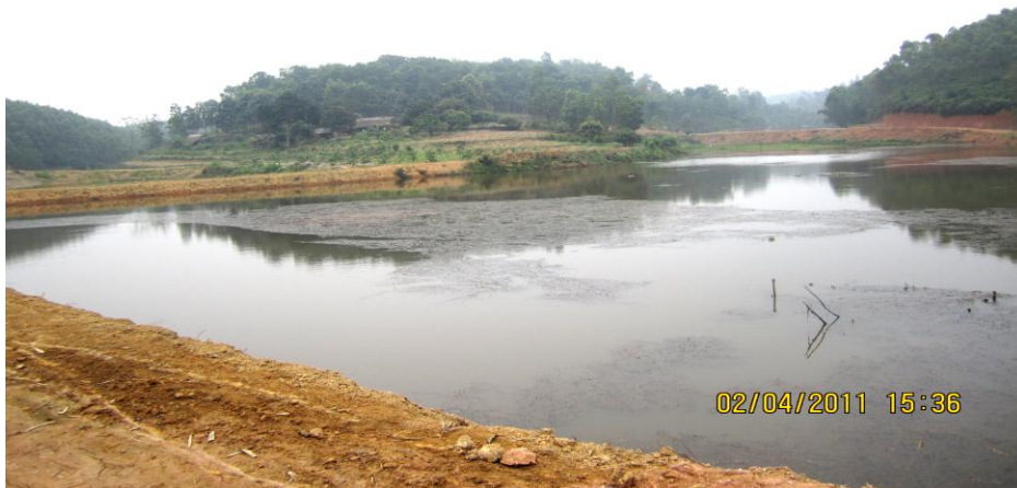
Hình 7 : Hệ thống RVAC tại Đuan Hùng - Phú Thọ
